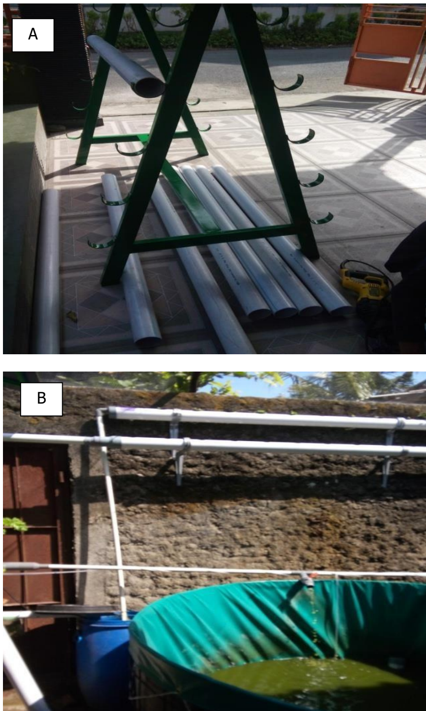
Gambar 1. a. Persiapan pipa untuk hidroponik. b. Instalasi pipa untuk sistem akuaponik
